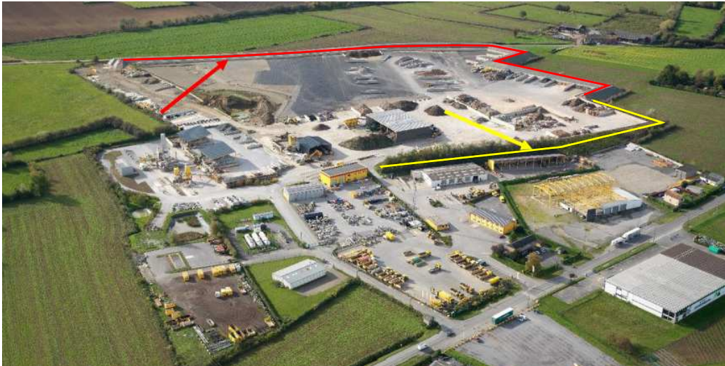
Photographie aérienne du site de LORBAN TP, Le trait jaune : merlon initial ; trait rouge : l'extension du merlon à la suite de l'extension du site.
